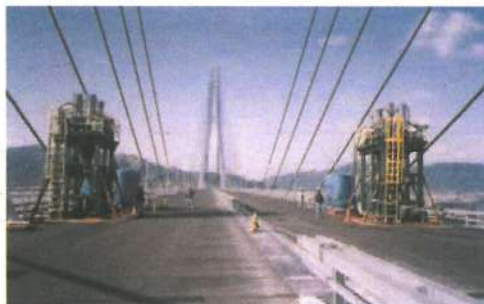
تصویر (۱۲) - آزمایش میرایی پل توسط مولدهای سنگین [۳]
