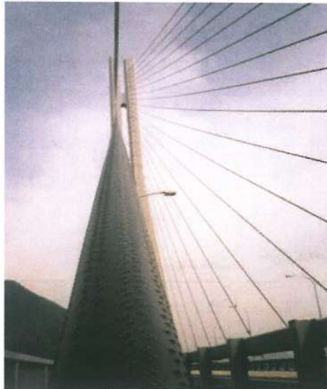
تصویر (۷) - نمایی از کابل‌های نگهدارنده پل [۳]
